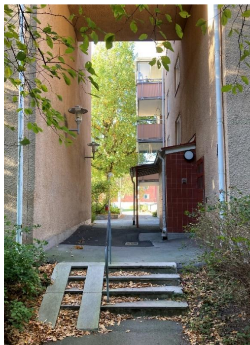
Höga valv mellan huskropparna ger fina vyer och bra kommunikation.
