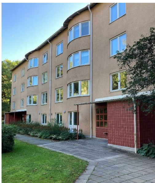
Hus E, gårdsfasaden.
