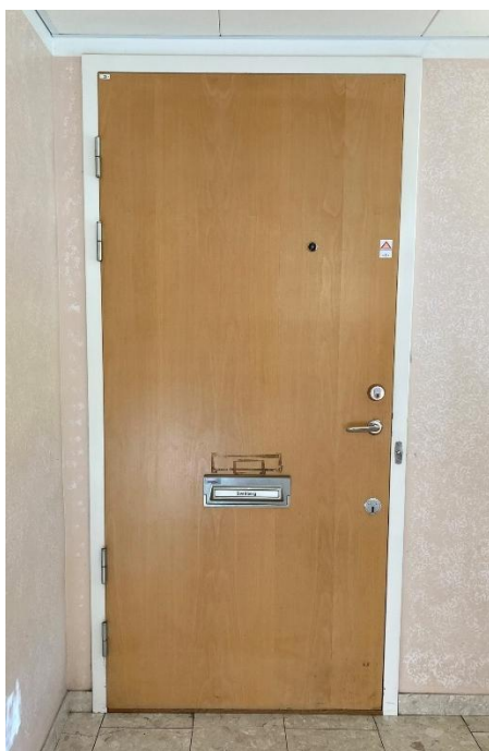
En ursprunglig lägenhetsdörr med trälaminat.
