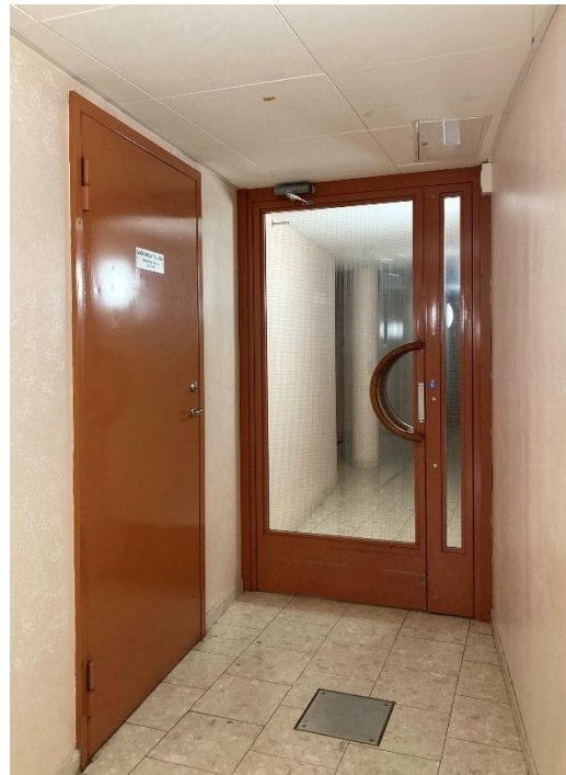
Olika dörrtyper till olika källarutrymmen, ståldörr, slät skivklädd dörr, glasad ståldörr.
