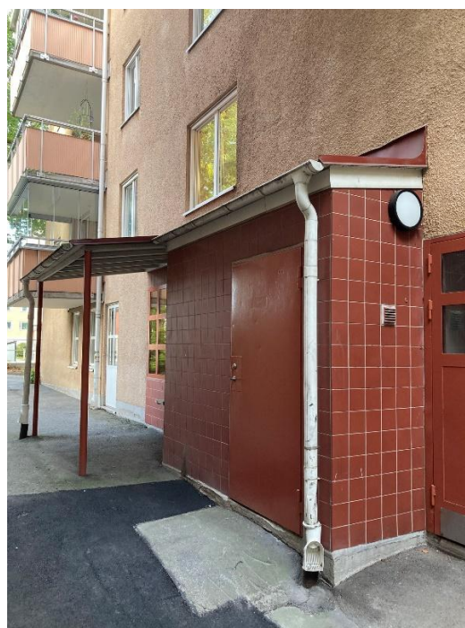
Entré med tak och i förgrunden soprum.
