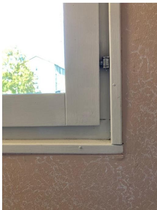
Fönsterdetaljer i trapphusen. Inre bågen är av trä.
