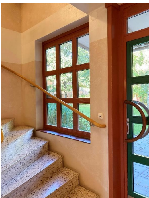
Huvudentréerna har grön innerdörr, för övrigt är dörr- och fönsterpartier rödmålade. Fönsterbänken är klädd med rött klinker.
